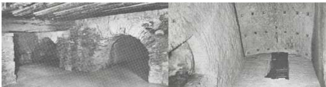
Die zwei Brennkammern der Ziegelhütte - Decke der Brennkammern mit den Luftlöchern
